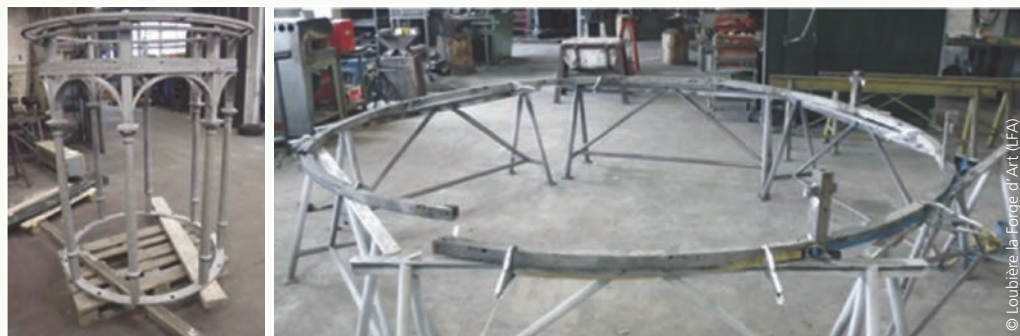
Figures 7 a, b : Restauration de la Gloriette en atelier assemblage des pièces métalliques de la structure
