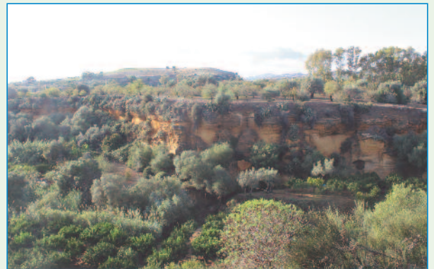
Retenue stockant l'eau qui alimentait la ville grecque d'Agrigente (Sicile). Elle a été creusée au Ve s. av. J.C. dans une ancienne carrière de faluns quaternaires.
