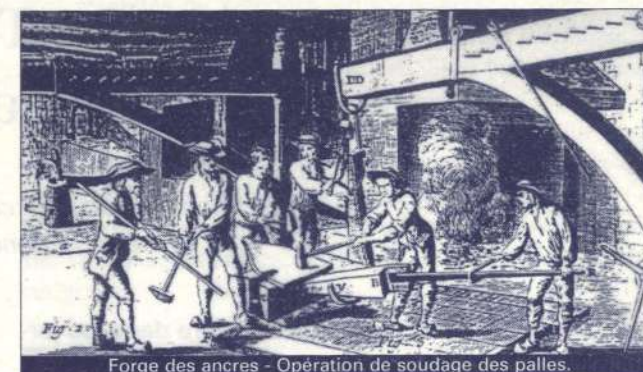
Forge des ancres - Opération de soudage des palles.
