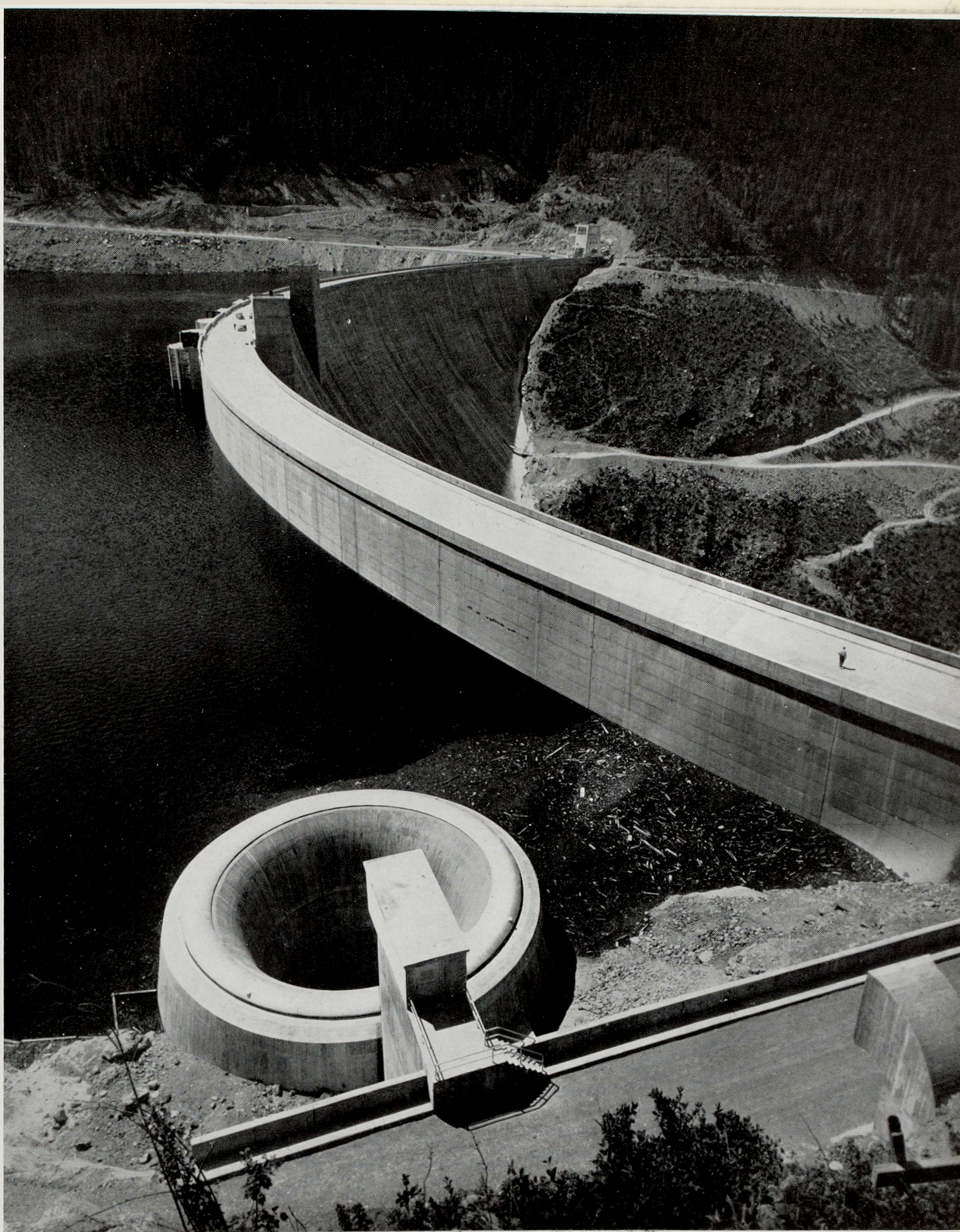
Barrage de Hungry Horse établi dans le Montana sur la rivière Flathead à 2 km au Nord-Est de Kalispell. Sa hauteur est de 171 mètres, sa longueur de 642 mètres. Il retient 3.086.200 mètres cubes d'eau. (Collection B.I.S.)
