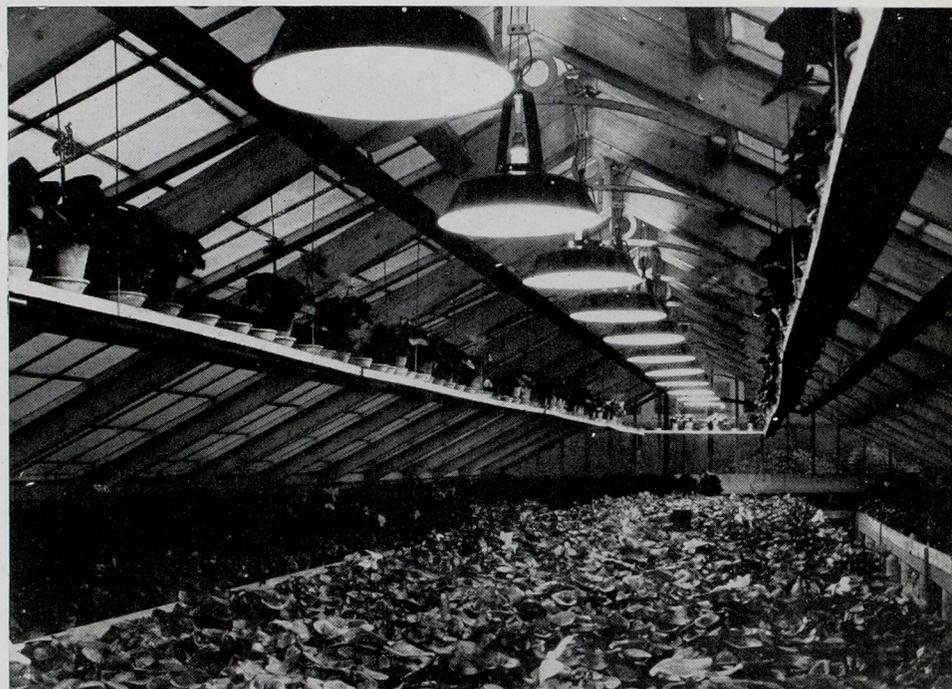
Cette serre de 43 m<sup>2</sup> a été équipée de 12 Reflectolux R 45, lampes de 200 watts 115 volts, alimentées sous 120 volts. Éclairage moyen : 500 à 600 Lux. (Établissements d'Horticulture ouvrière, Vaucresson).
