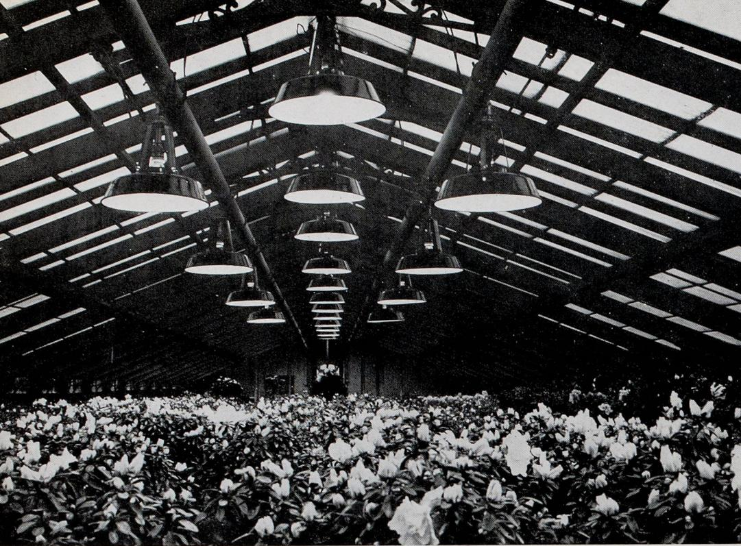
Cette serre de 48 m<sup>2</sup> a été dotée de 23 Reflectolux équipés de 10 lampes à incandescence 100 watts, 9 lampes à incandescence 200 watts, 4 lampes mercure M A 125 watts. (Éts. Truffaut, à Versailles.)
