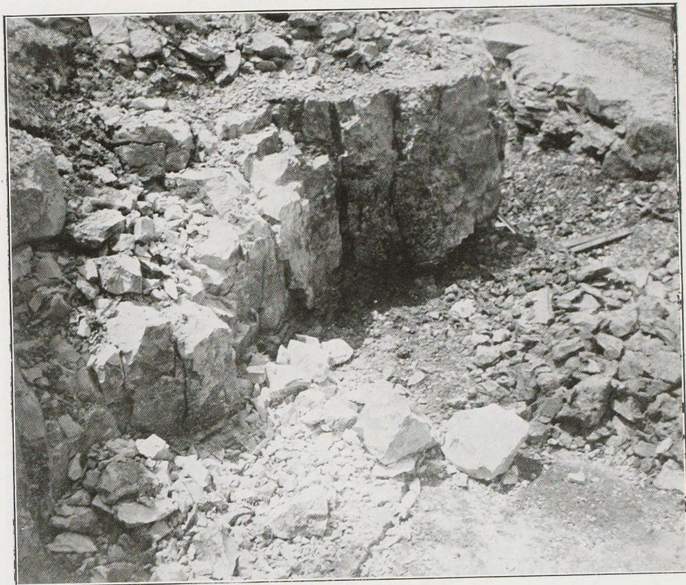
FIG. 10. — 21 juin 1934. Le dernier coup de mine dans le banc calcaire superposé au gîte.
