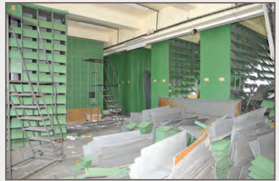
Armoires fixes de l'ancien dispositif en cours de démontage
