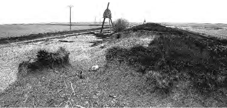
FIGURE 2. Brèche créée par une surverse dans la digue dormante du Maroc. Les eaux d'inondation venaient du polder de 1965 (à droite sur cette photographie) et ont creusé une sorte de cirque dans le revers de la digue (photo F. Verger).
